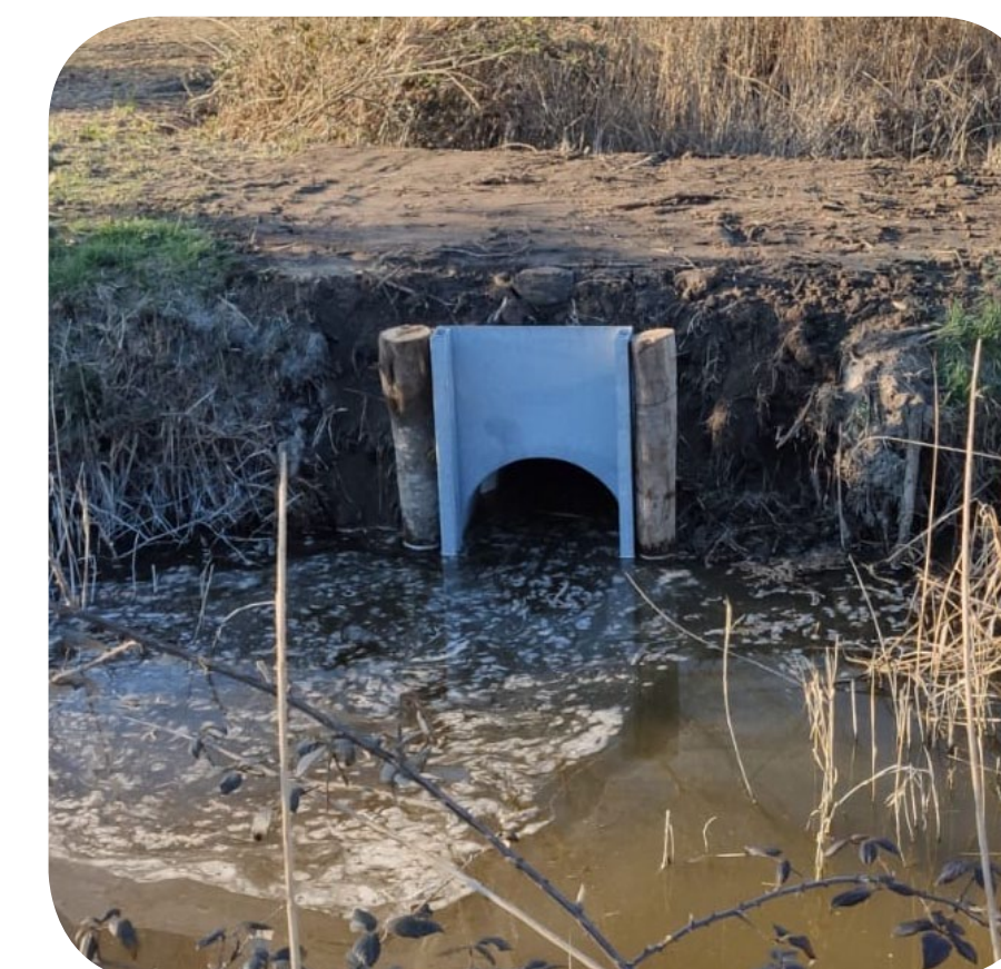
Nuova "chiavica" installata
