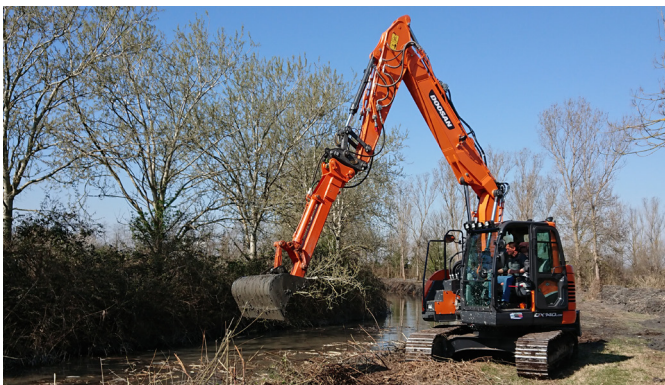
Fig. 1, 2. Dragaggio del canale e consolidamento dell'argine / Dredging of the canal and consolidation of the embankment
