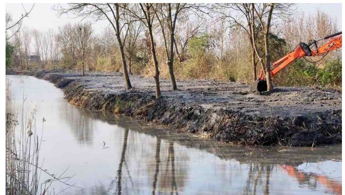
Fig. 1, 2. Dragaggio del canale e consolidamento dell'argine / Dredging of the canal and consolidation of the embankment
