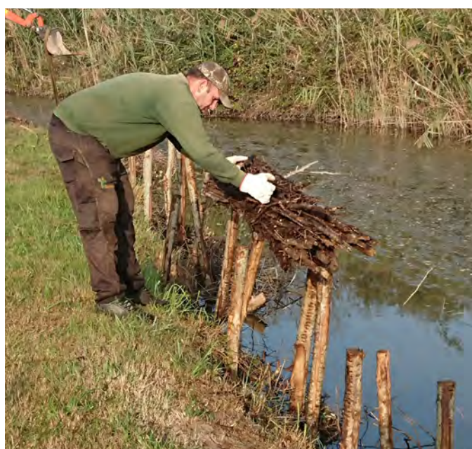
Posa di una fascina.
