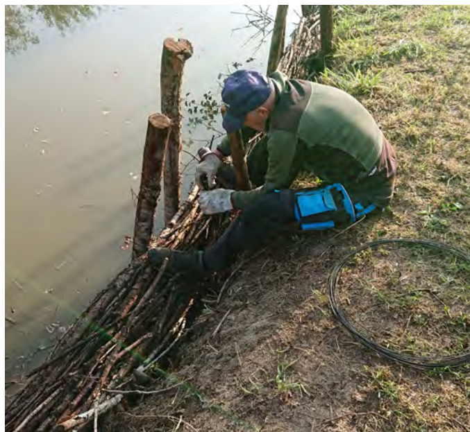
Stabilizzazione delle fascine con collegamenti a filo di ferro.
