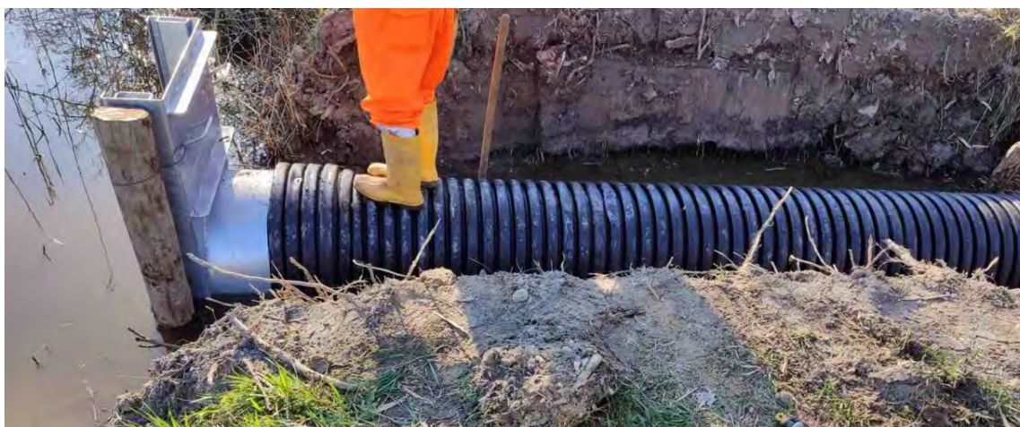
Posa del manufatto (tubo e chiuse)
