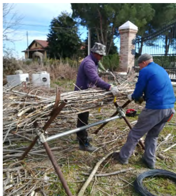
Raccolta e confezionamento delle fascine
