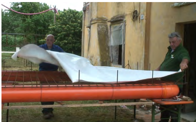
Applicazione del geotessuto
