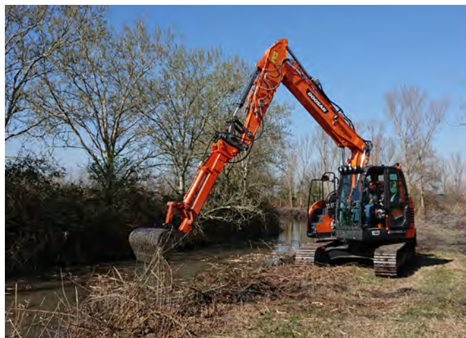
Dragaggio del canale
