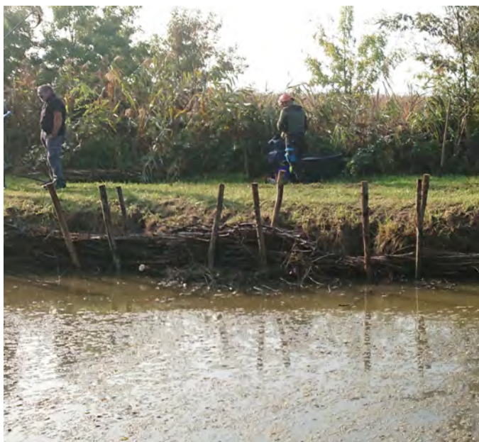
Argine del canale con le fascine in corso di posa.
