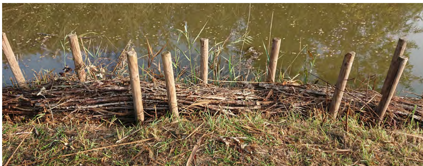
Modulo di fascina posata (in attesa del taglio della misura in eccedenza dei pali di contenimento).
