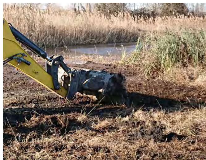
Rimodellamento del suolo con escavatore
