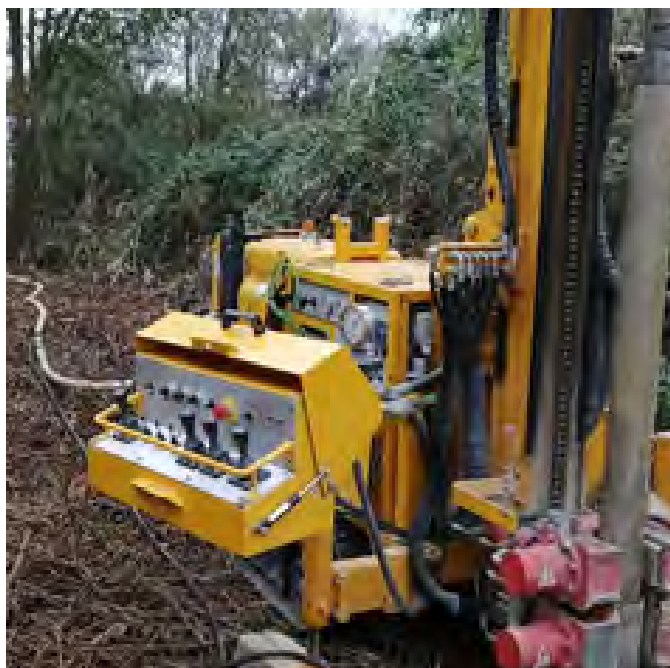
Preparazione del piezometro
