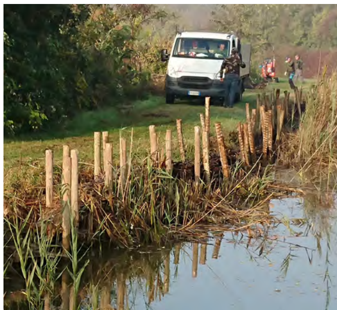
Argine del canale con fascine posate.
