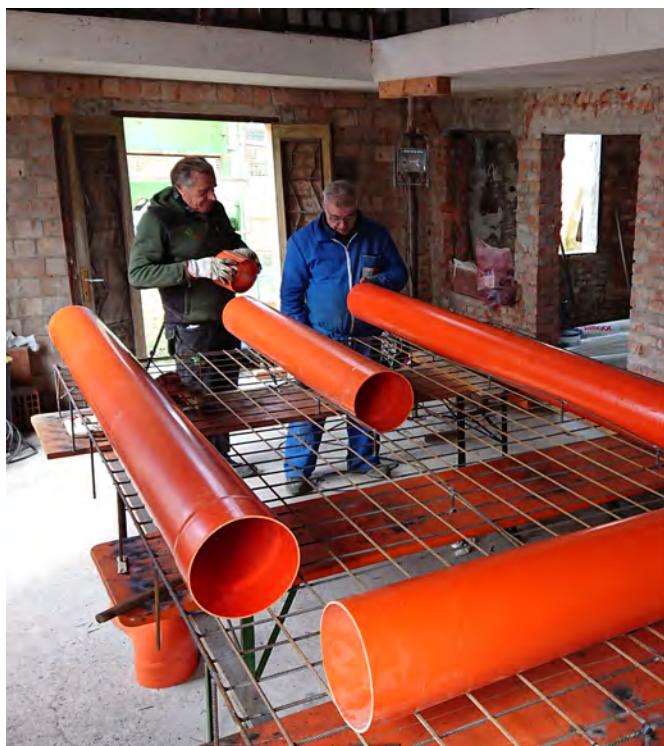
Montaggio dell'intelaiatura dei tubi in pvc sulla rete elettrosaldata.
