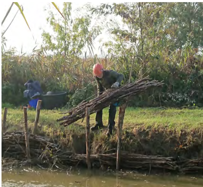
Posa di una fascina.
