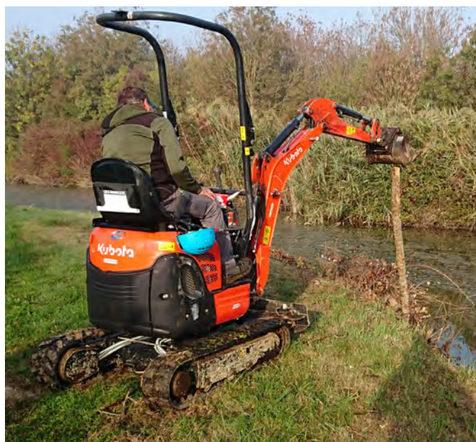
Infissione dei pali con escavatore.
