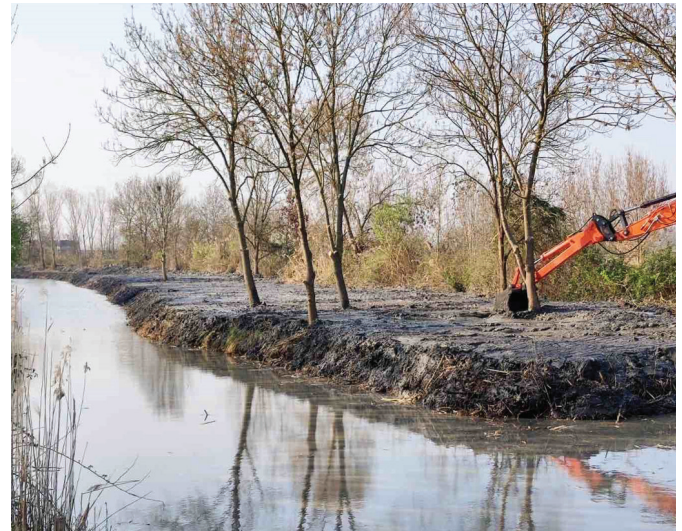
Fig. 1, 2. Dragaggio del canale e consolidamento dell'argine / Dredging of the canal and consolidation of the embankment
